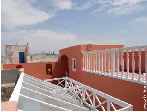
vue depuis la terrasse sur toit
