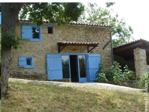
Equipements extérieurs à disposition des hôtes
