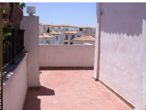
terrasse sur toit
