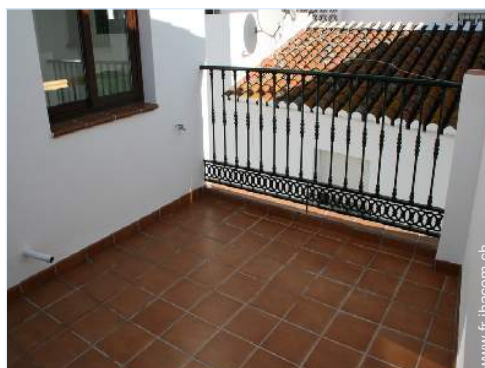
vue depuis la terrasse sur toit
