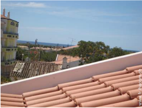
vue depuis la terrasse sur toit
