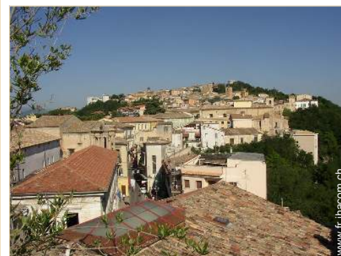
vue depuis la terrasse sur toit
